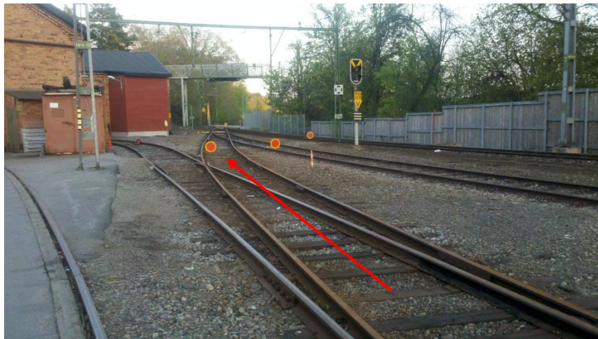
Figur 8. Bilden visar Neglinge bangård, växelområdet i änden mot Saltsjöbaden. Pilen pekar i den riktning fordonen rullade och mitt i bild ses korsningspartiet i växel 6.
