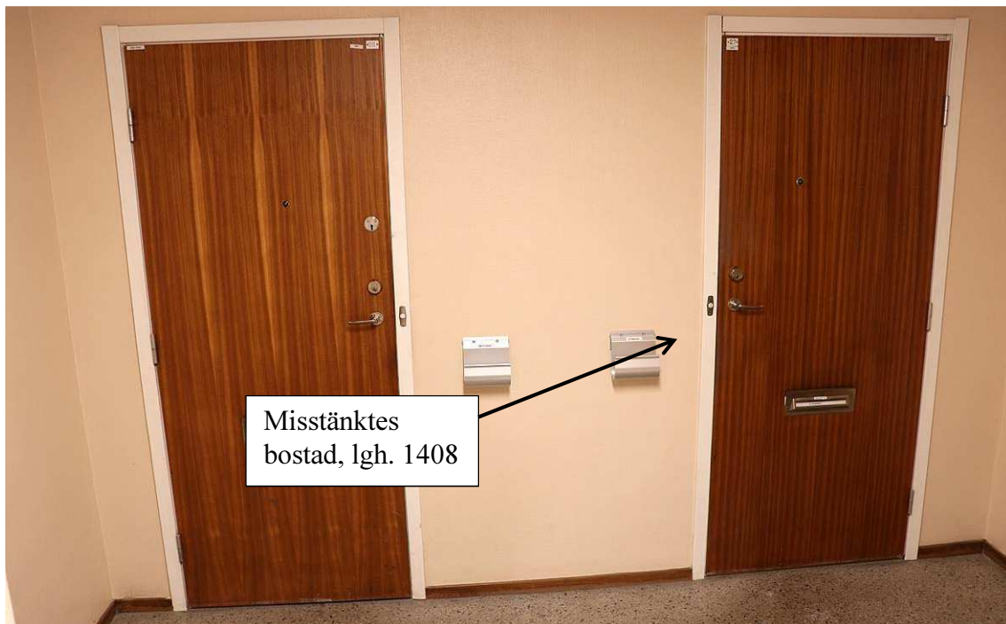
Figur 4. Översiktsbild av lägenhetens entrédörr. Ovan bild är tagen med vidvinkelobjektiv.
